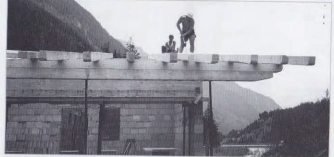
Baustelle KK Schießstand Grantau
